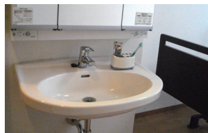
車いす対応洗面台
