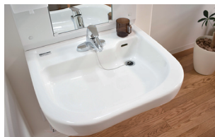
車いす対応洗面台 (ベストライフ山科)
