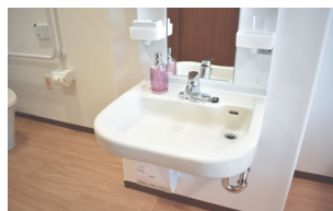
車いす対応洗面台
