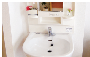
車いす対応洗面台
