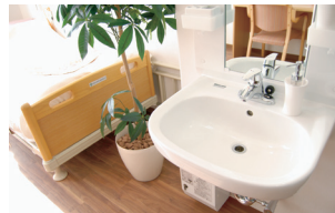
車いす対応洗面台
