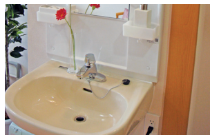
車いす対応洗面台
