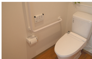
温水洗浄トイレ (ベストライフ金沢文庫II)
