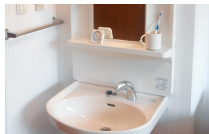
車いす対応洗面台(ベストライフ東村山II)
