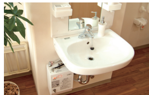
車いす対応洗面台
