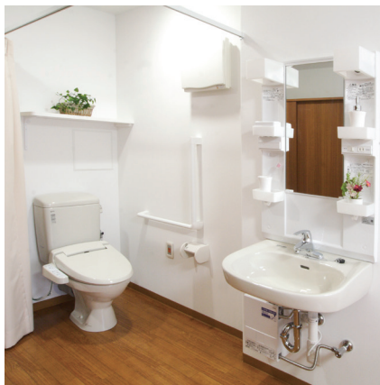
車いす対応洗面台と温水洗浄トイレ
