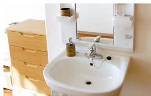
車いす対応洗面台
