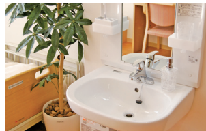
車いす対応洗面台
