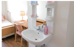
車いす対応洗面台
