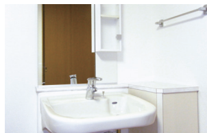
車いす対応洗面台
