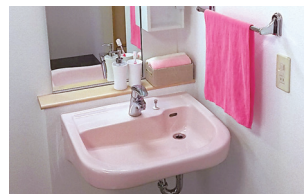
車いす対応洗面台
