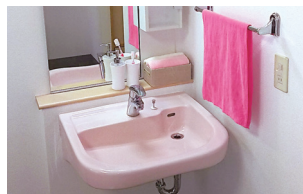
車いす対応洗面台
