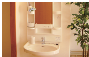
車いす対応洗面台
