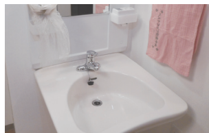
車いす対応洗面台
