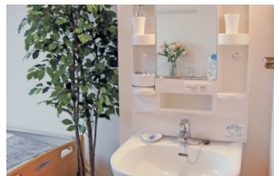
車いす対応洗面台
