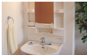
車いす対応洗面台
