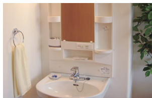
車いす対応洗面台
