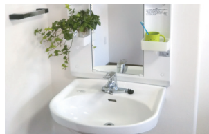
車いす対応洗面台
