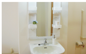
車いす対応洗面台
