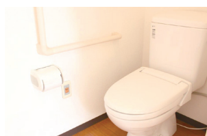
暖房便座トイレ
