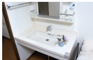
車いす対応洗面台
